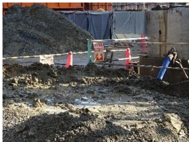
水分が多い掘削土の仮置き
