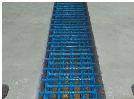
床版継手部の配筋状況
