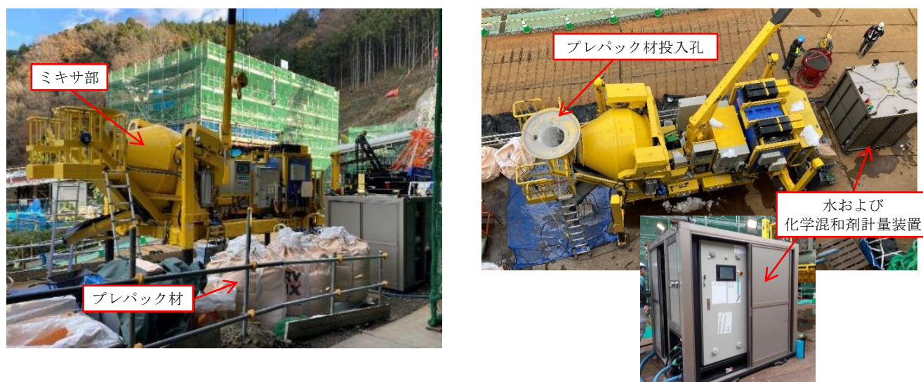
写真-1 プレパック材と移動式プラント
