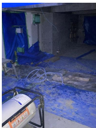
写真-4 冬期施工時の養生対策状況
