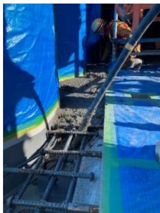
写真-2 STC50N の打設状況
