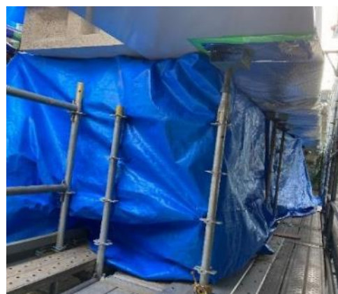
写真-4 冬期施工時の養生対策状況
