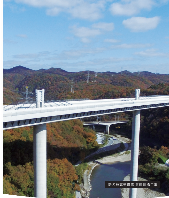
新名神高速道路 大戸川橋他2橋(PC上部工)工事 ①
