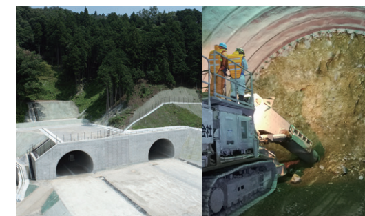
新東名高速道路 谷ヶ山トンネル西工事
