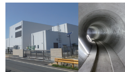
第80工区 玉川ポンプ場建設工事
