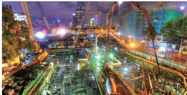
ホーチミン都市鉄道建設工事ペンタイン - スオイティエン区間(1号線)パッケージ1a ⑦
